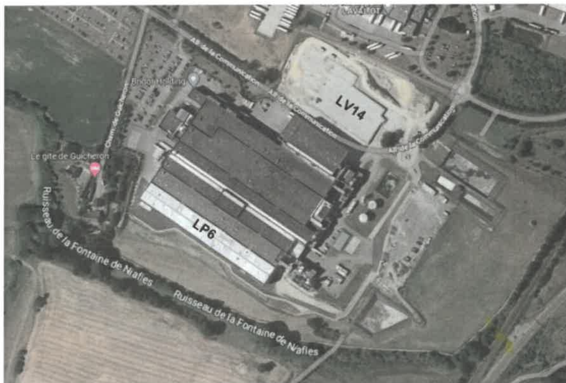
Figure 6 : Vue aérienne de LP6 (source géoportail)
